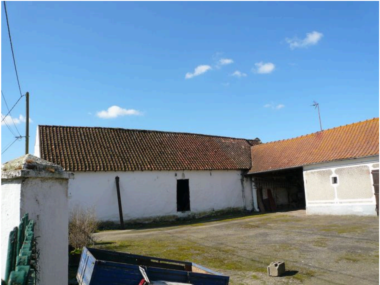
Vue de la grange.
