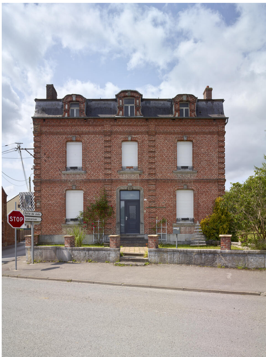
Glageon, ancienne maison d'industriel, dite maison Hubinet.
