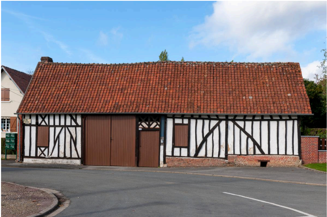
Ancienne grange avec porte à engranger et entrées charretière et piétonne, n°2 rue du Bois, vue depuis l'est.
