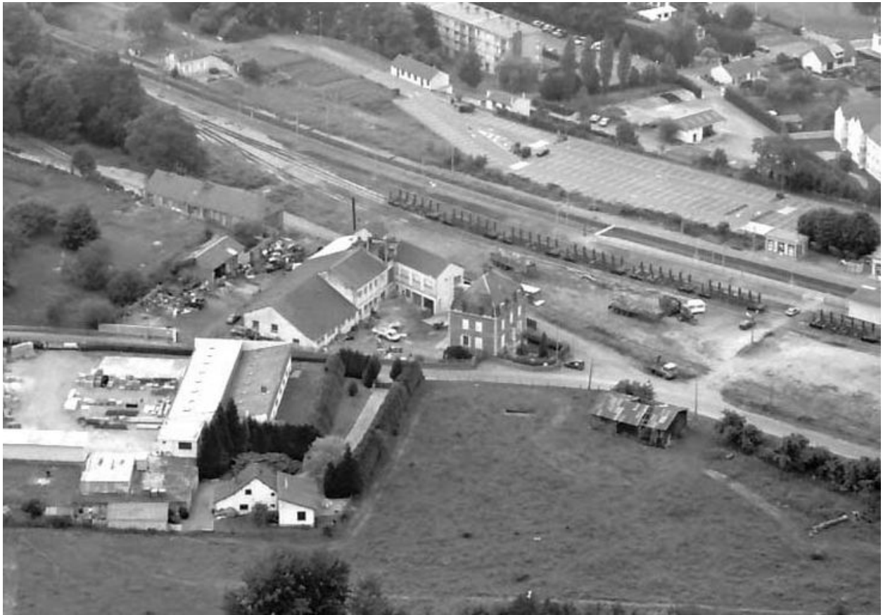
Vue aérienne de la laiterie en 1994.
