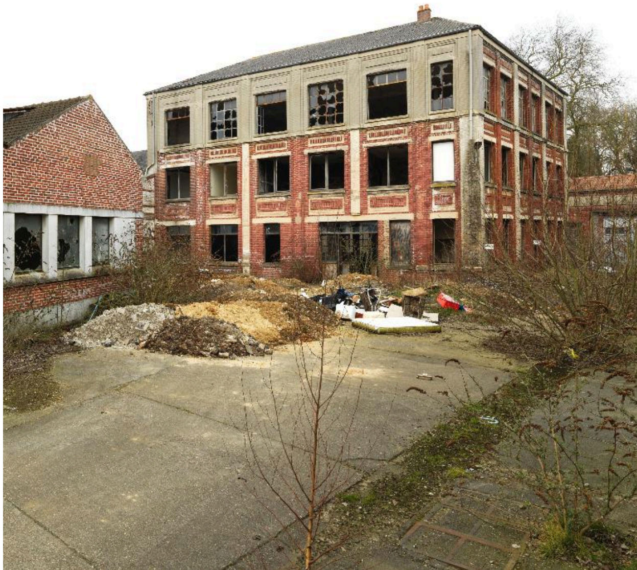
Vue de la façade postérieure du bâtiment principal sud.
