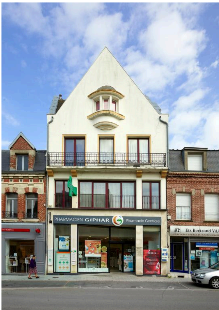
Pharmacie, n° 4 rue de Péronne. Vue de la façade principale. La façade sur rue est un haut pignon triangulaire, percé en son centre par un petit bow-window.
