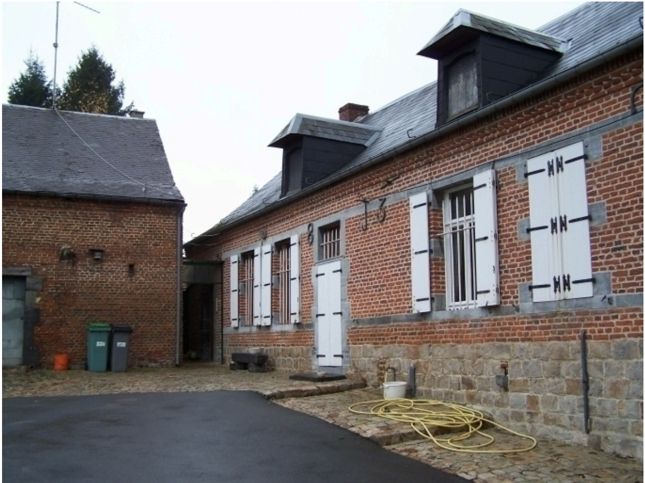
Vue du logis et d'une partie de l'étable.
