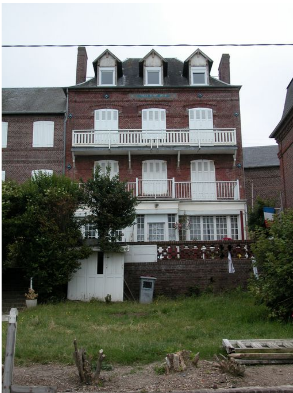
Vue d'ensemble côté mer.
