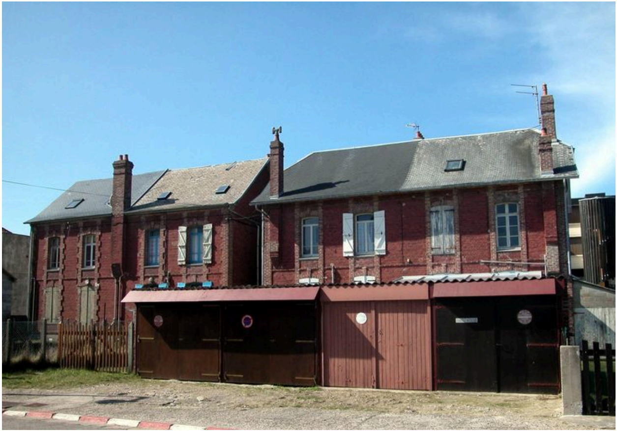
Façades postérieures, vue depuis la rue Saint-Martin.
