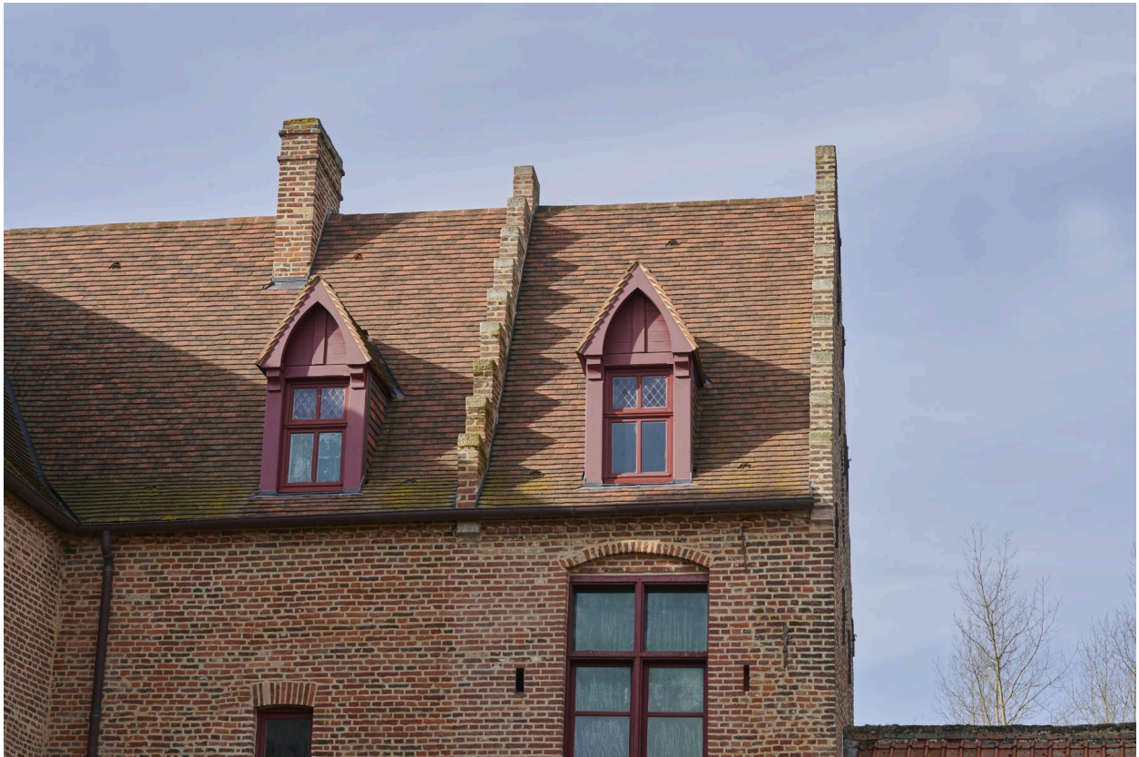
Détails de la toiture couvrant la tour porche et le logis du XVI e siècle.
