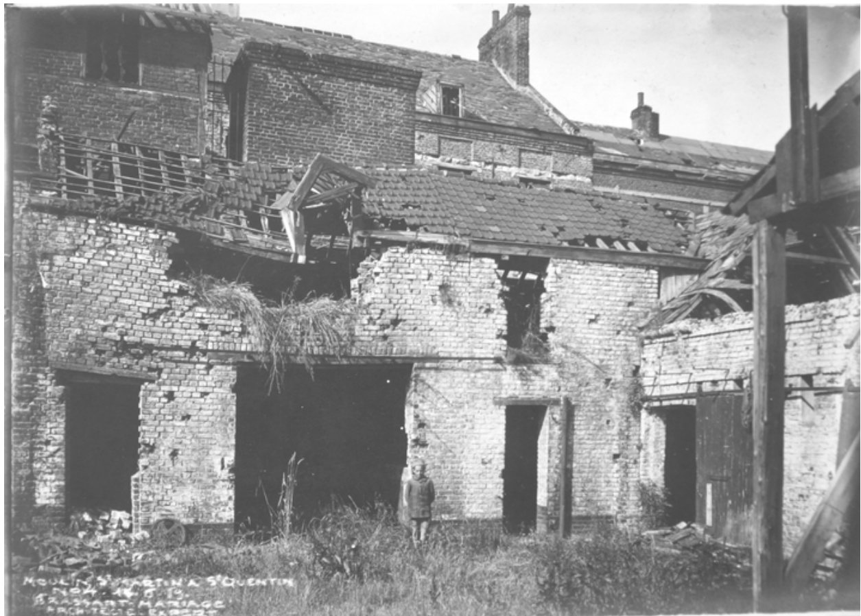
Chaufferie (premier plan), salle des machines et minoterie (toiture à l'arrière plan) photographiées depuis la cour intérieure en juin 1919 (AD Aisne).
