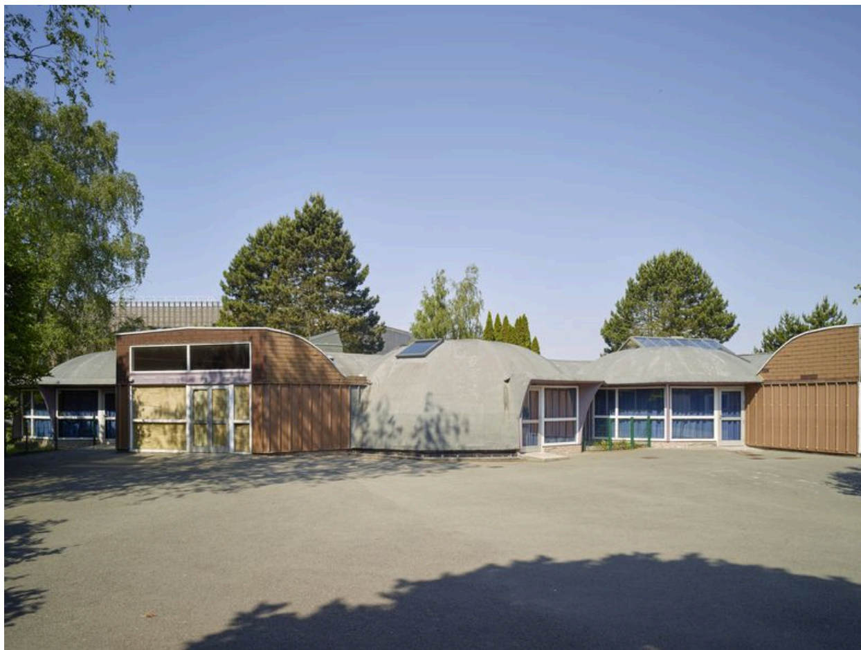
Partie sud de l'école élémentaire.
