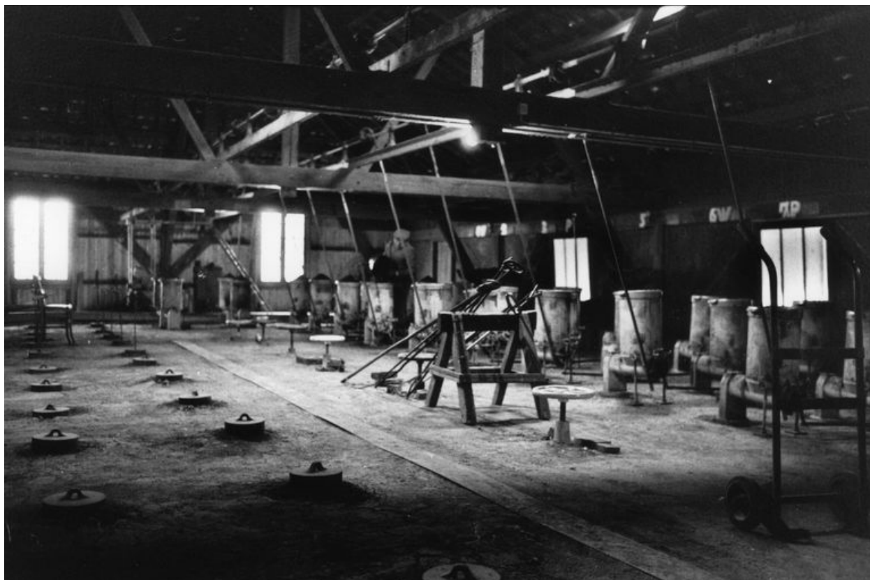
Vue du dessus du four Hoffmann avec son système automatique de chargement du charbon, état en 1989 (AD Oise).
