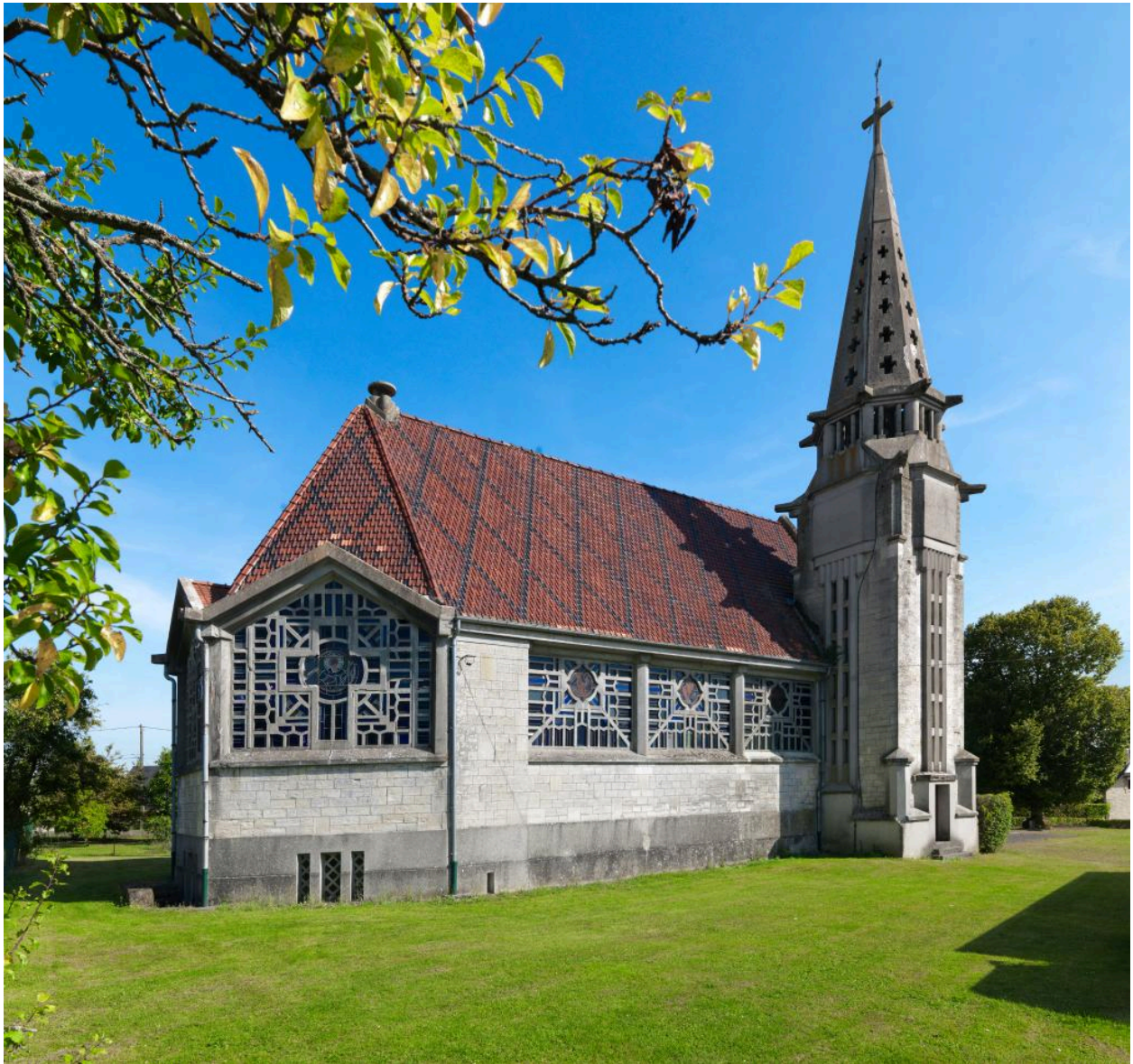
Vue générale, depuis le nord-ouest.
