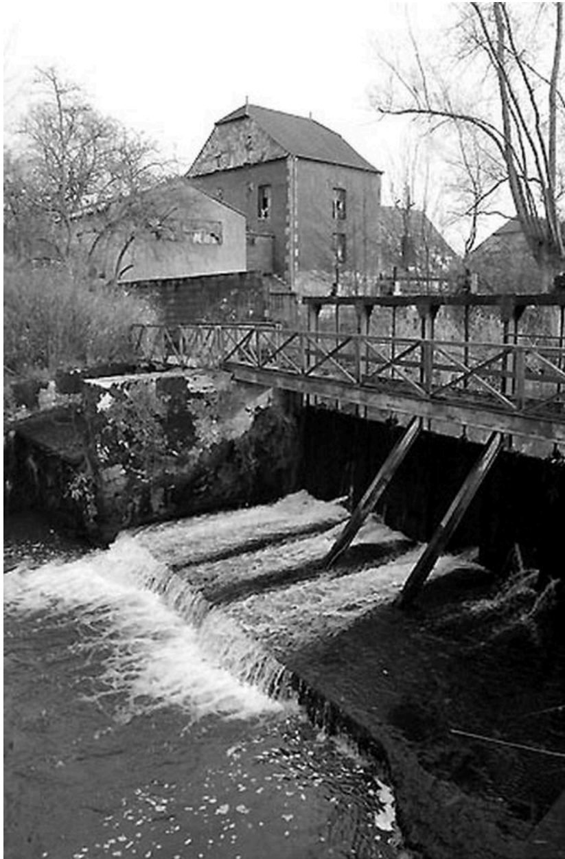
Vue des bâtiments du moulin et du barrage.
