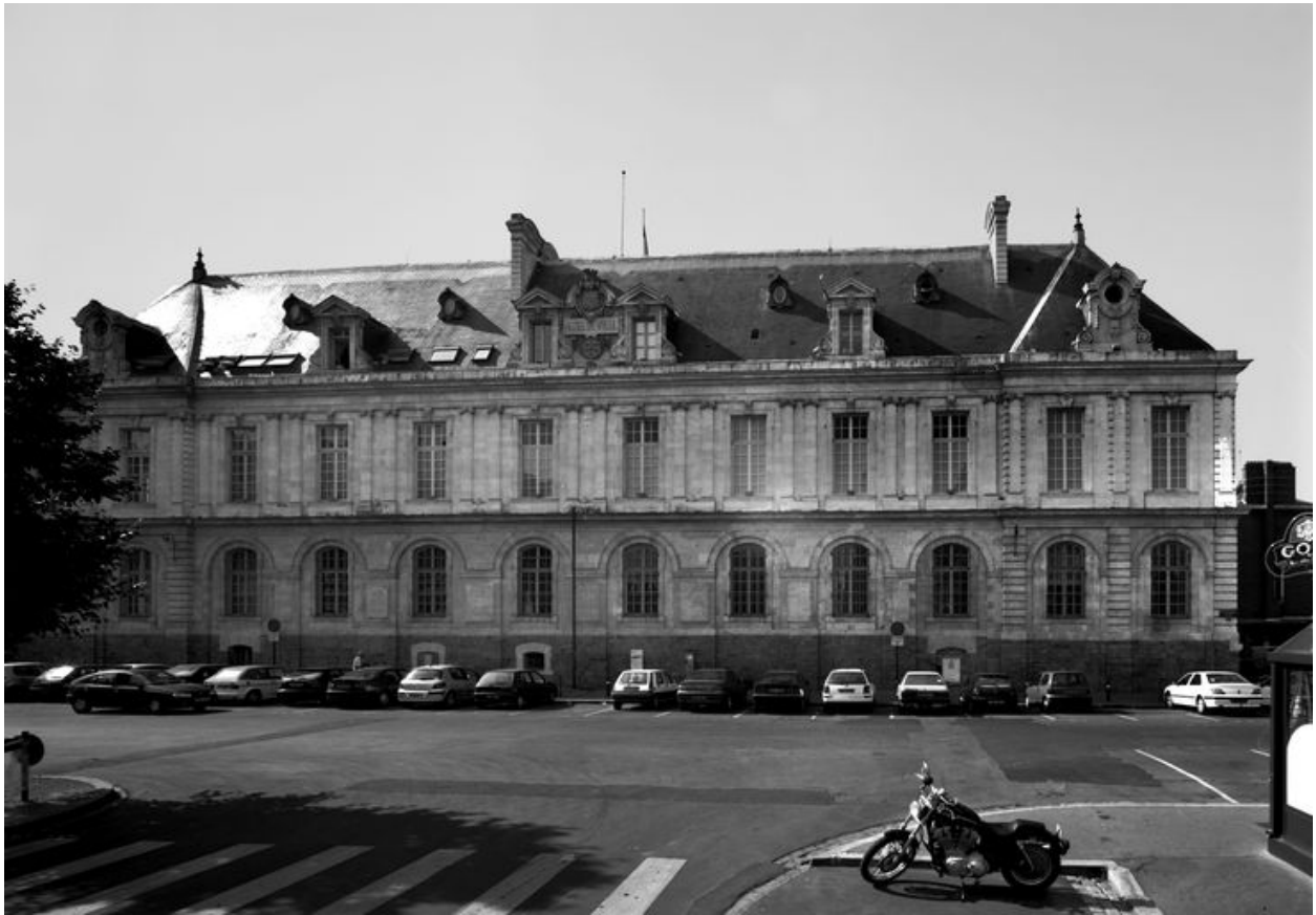
Vue de la façade nord.
