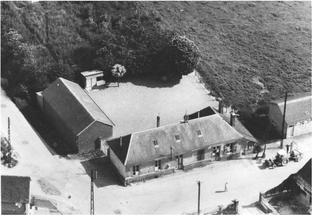
Vue aérienne depuis le nord, photographie, 1970 (AC Vauchelles-lès-Domart).
