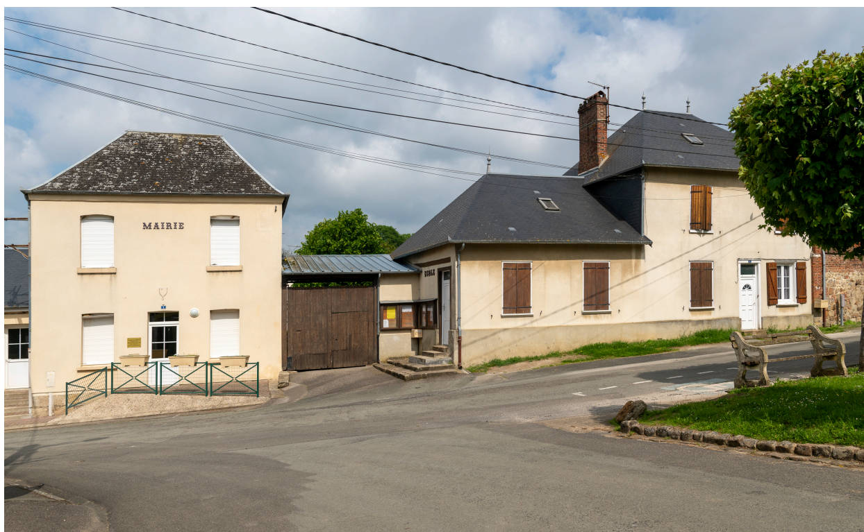
Mairie et école, n°1 rue de l'École, vue depuis l'est.
