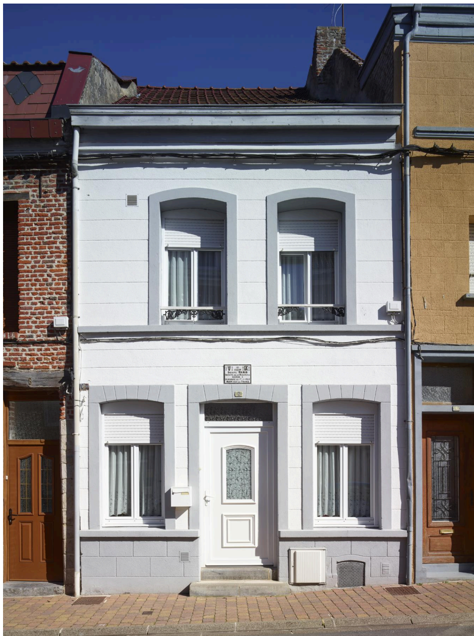
Maison du XVIII e siècle : façade avec symétrie axiale mais nombre différent de baies aux deux niveaux, la porte étant située au centre - 6, rue Tanis.
