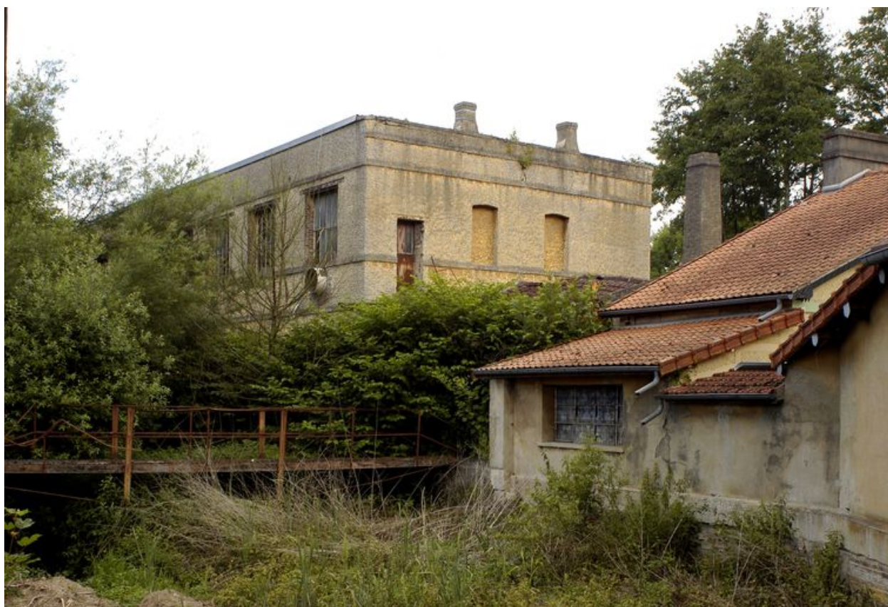
Vue d'ensemble postérieure du moulin à foulon.
