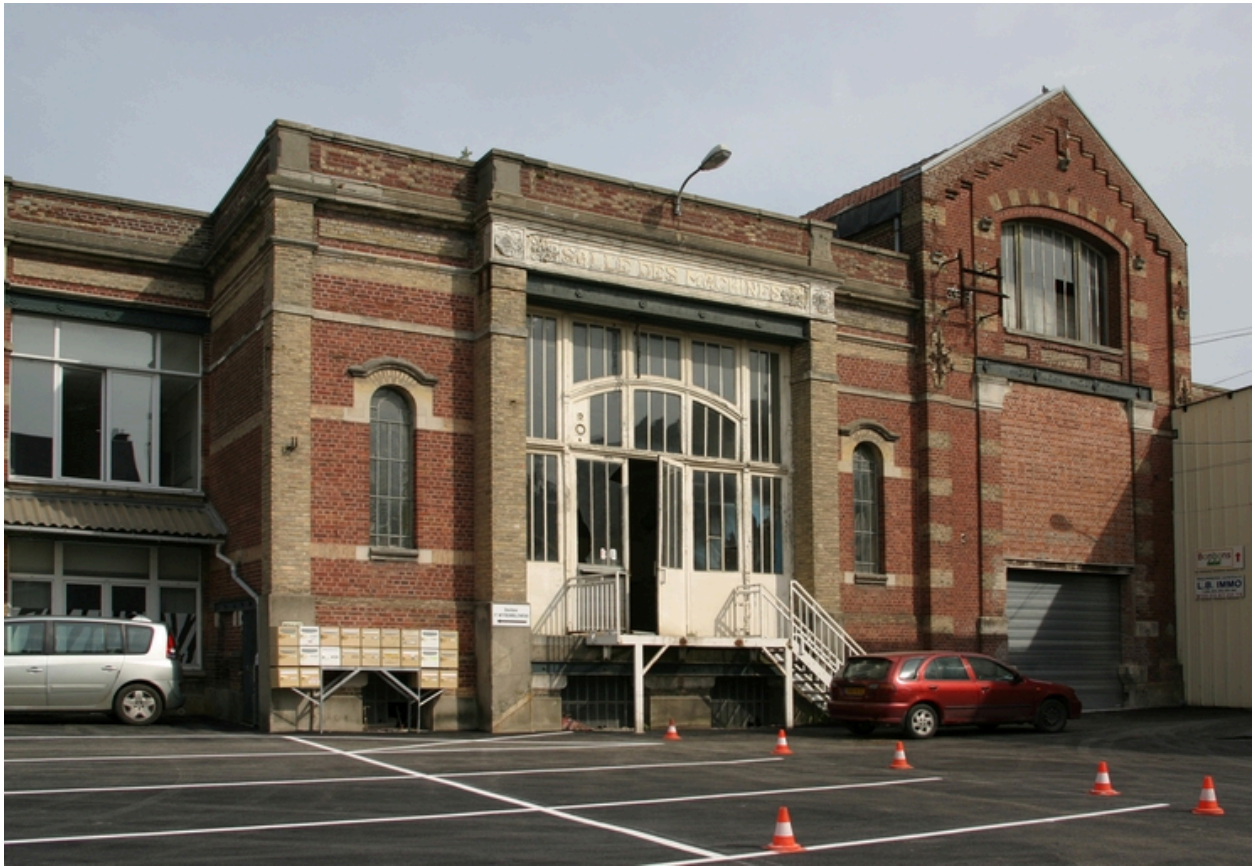
Salles des machines des années 1870 (à droite) et de 1913 (à gauche).
