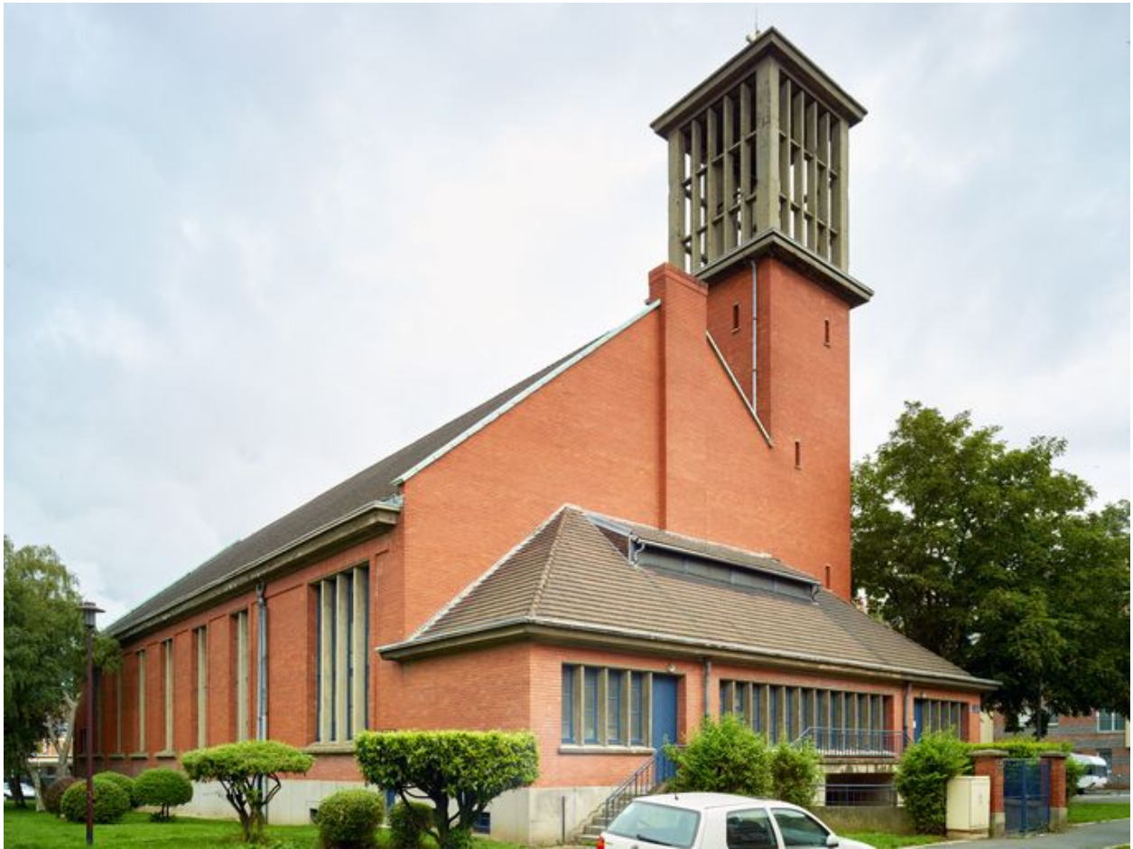
Élévation postérieure de l'église.
