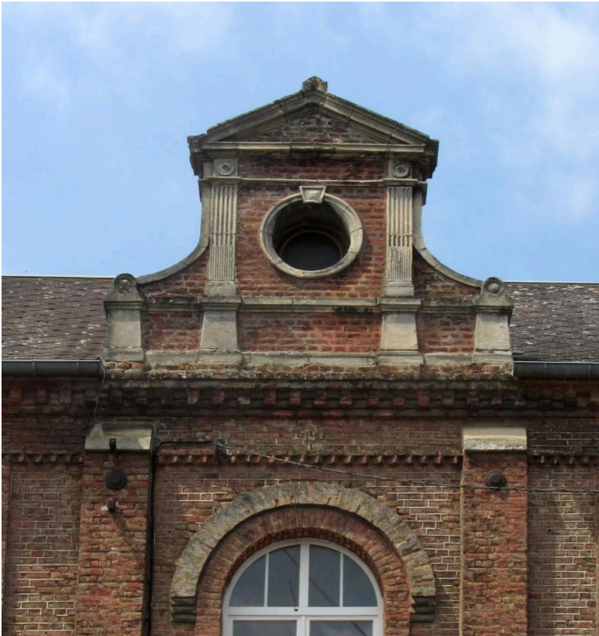
Détail du fronton de la façade sur rue.
