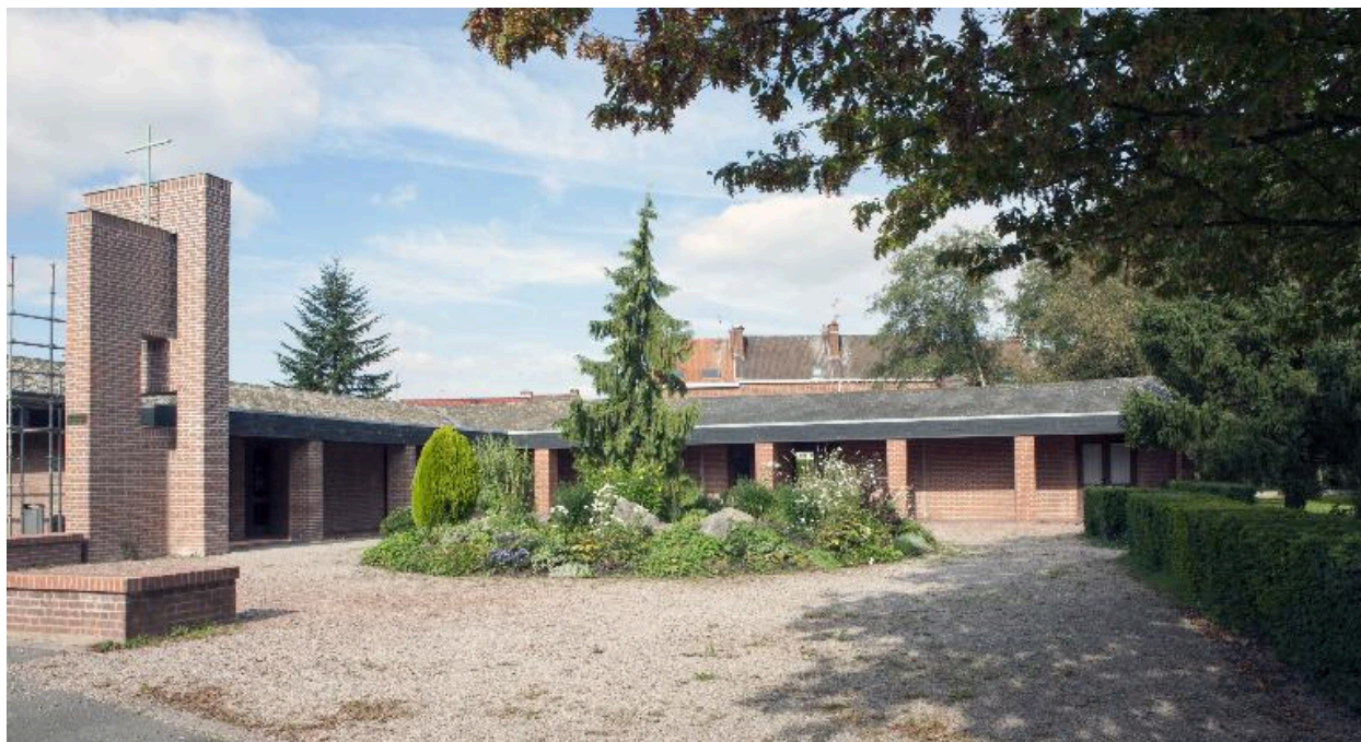
Élévation antérieure de la chapelle.
