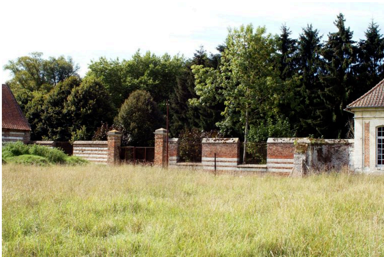
Mur de clôture du potager, intérieur.
