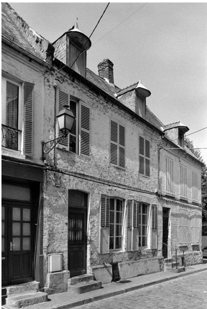
Vue de la façade principale sur rue.
