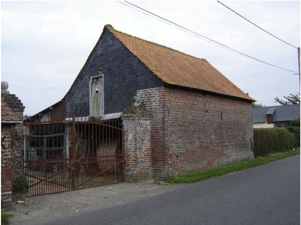
Vue de la charreterie sur rue.
