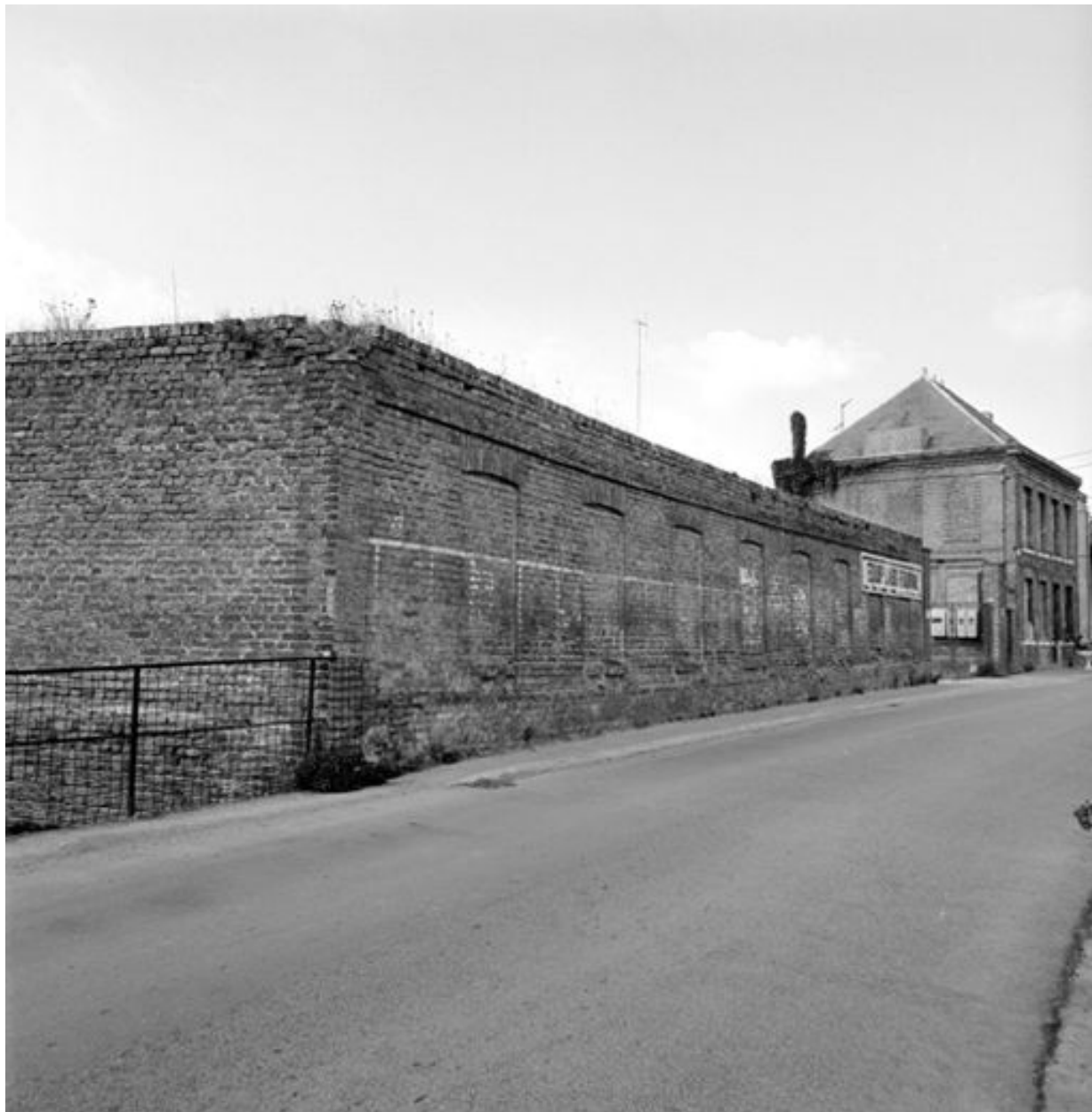
Atelier de fabrication, vestiges de l'élévation antérieure.
