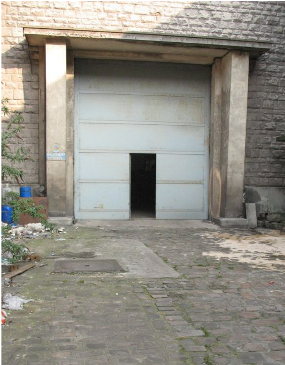
Porte d'entrée des entrepôts Boufflette.
