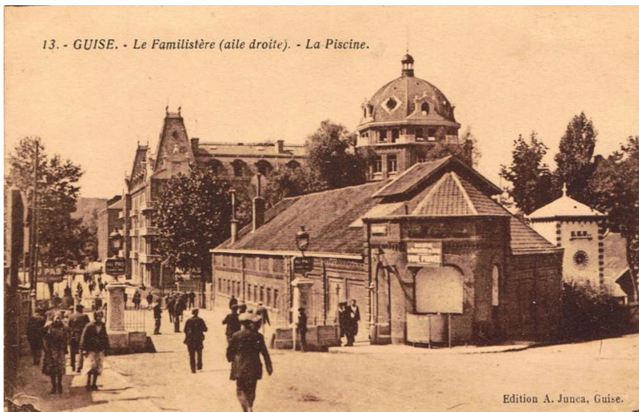
Vue du bâtiment du lavoir-buanderie-piscine du Familistère de Guise, carte postale, vers 1900 (coll. part.).
