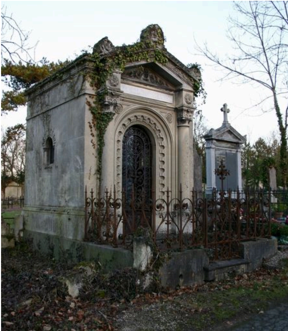
Vue générale, depuis le côté.
