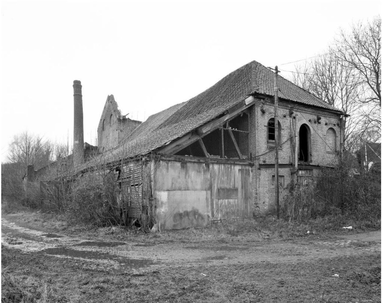
Ferme des Berceaux en 1999 : partie nord : les bâtiments de la râperie vus du nord-est.
