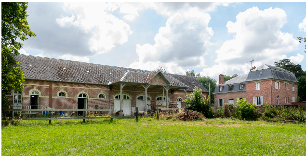
Écuries et logis du régisseur de la ferme.
