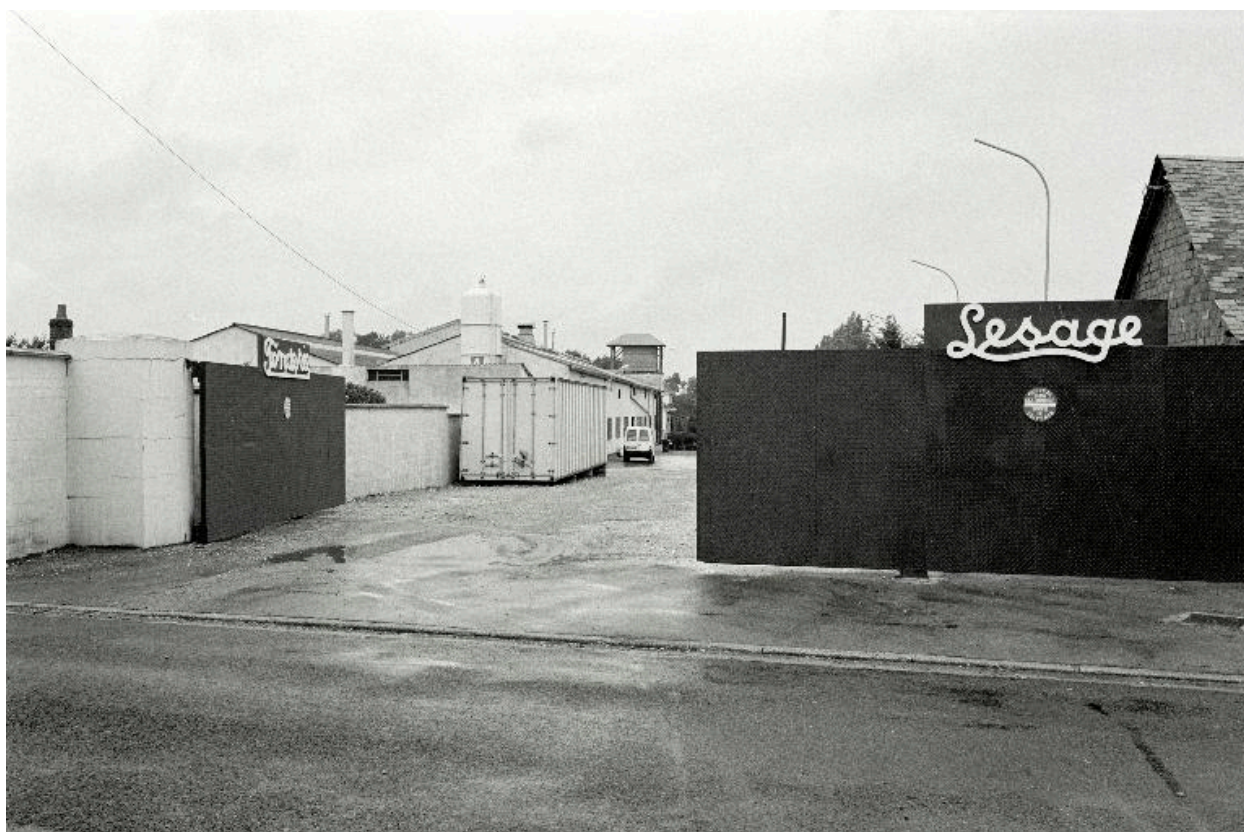
Fonderie Lesage, entrée du site, 75 rue Jean-Baptiste-Clément.
