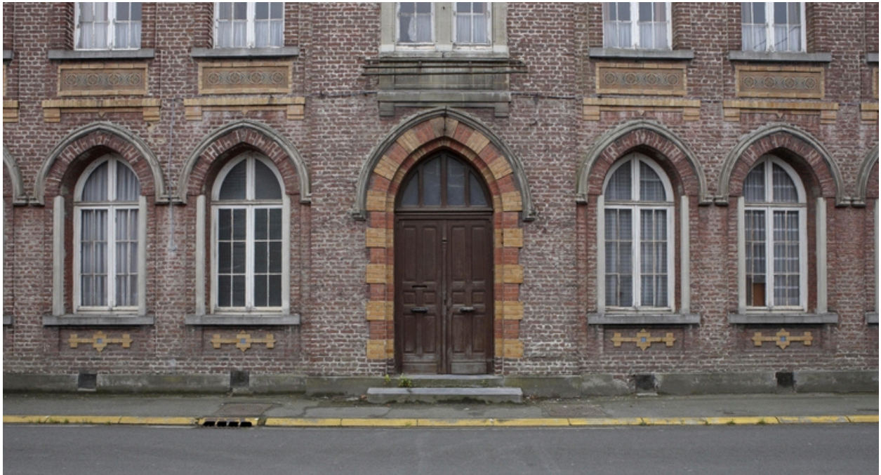
Le rez-de-chaussée de l'entrée principale.
