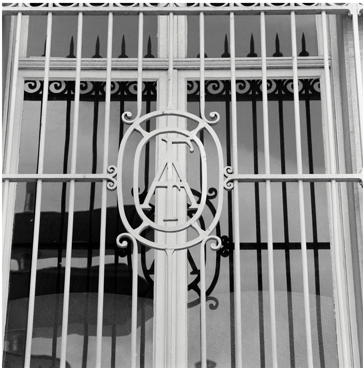
Élévation antérieure. Bureaux. Ferronnerie aux initiales de Agache et Fils.
