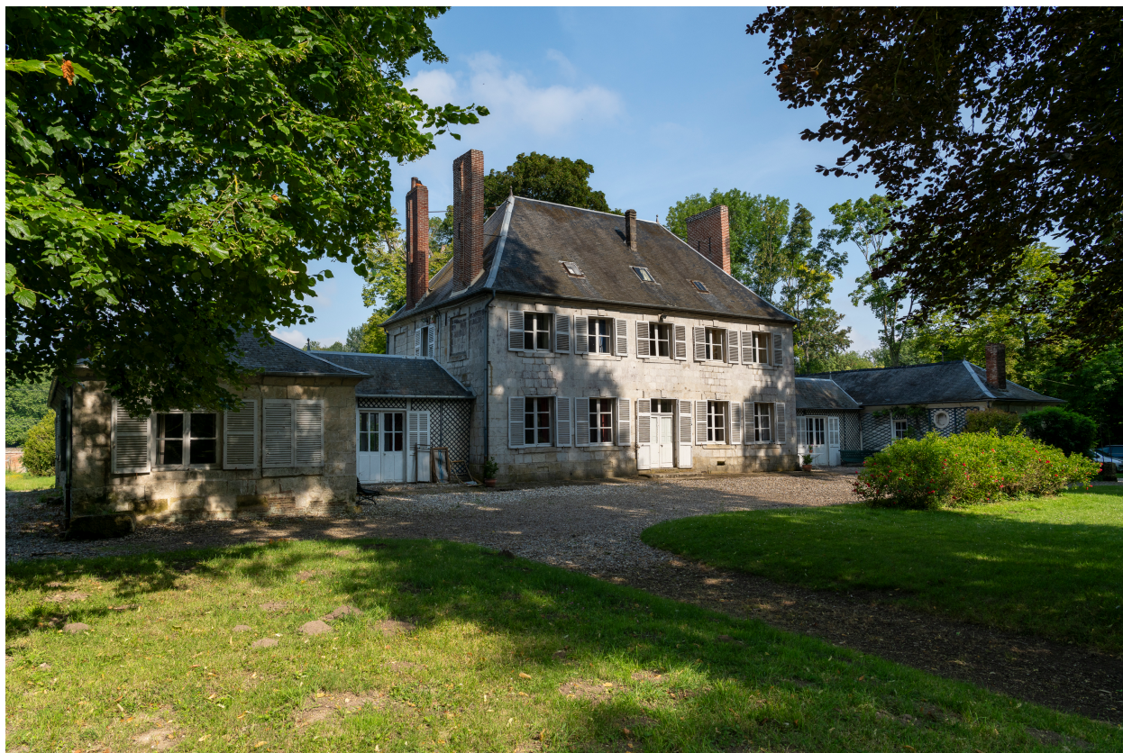
Logis, vue depuis le nord-ouest côté parc.
