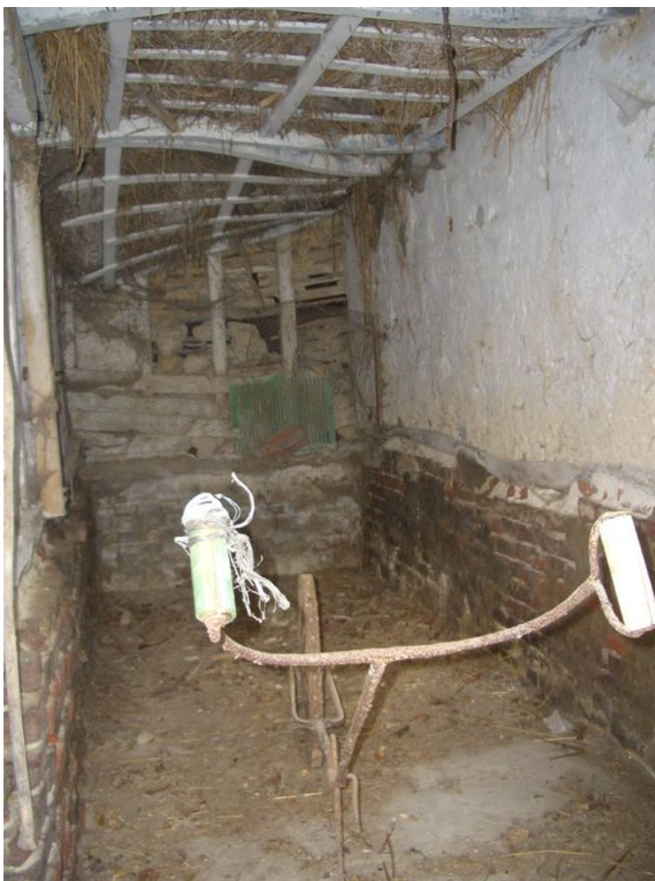
Vue intérieure d'une étable à cochon.
