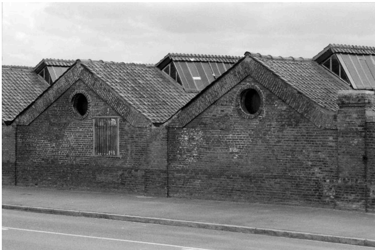
Atelier de fabrication, vue partielle, flanc nord-est.
