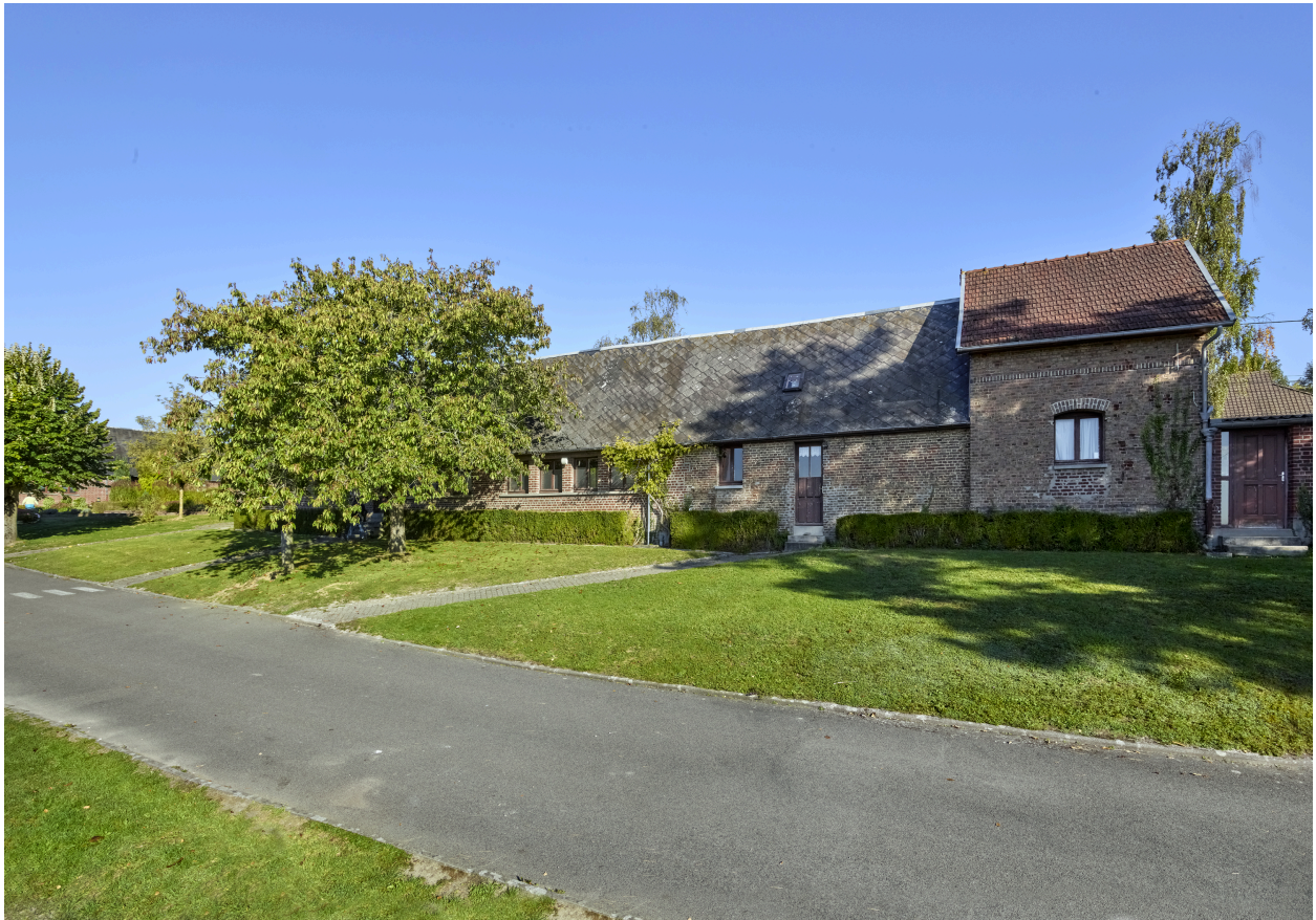
Vue d'une des dépendances, depuis le sud.
