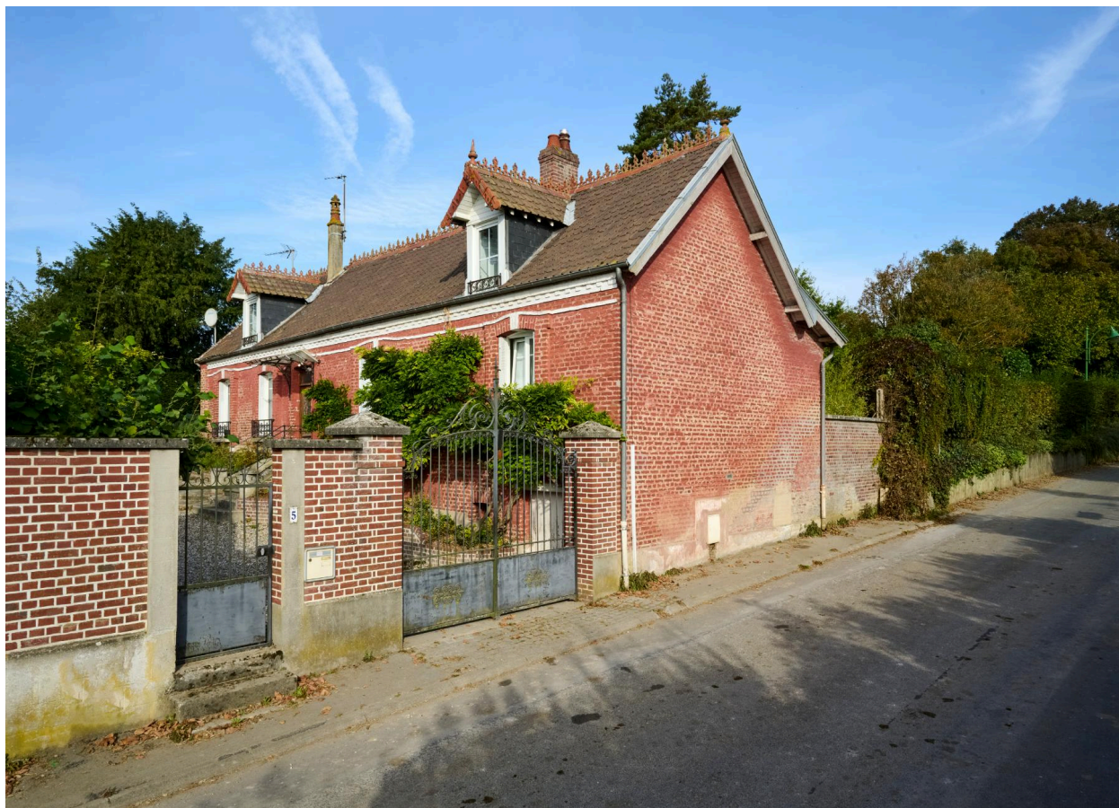
Maison, depuis le sud-est.
