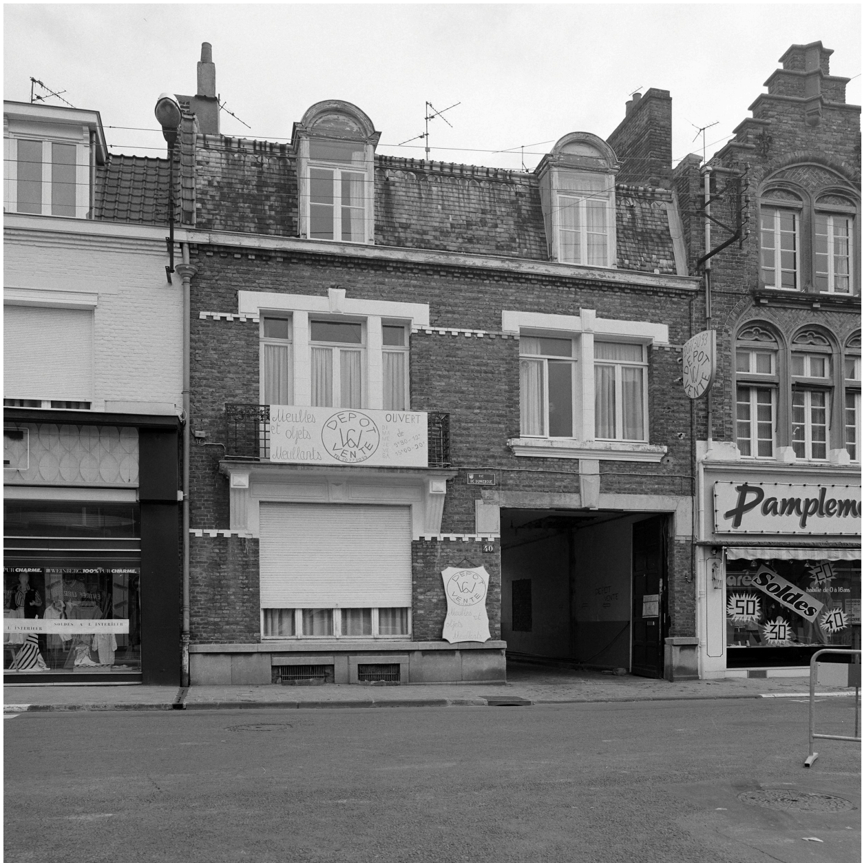
Élévation antérieure rue de Dunkerque.
