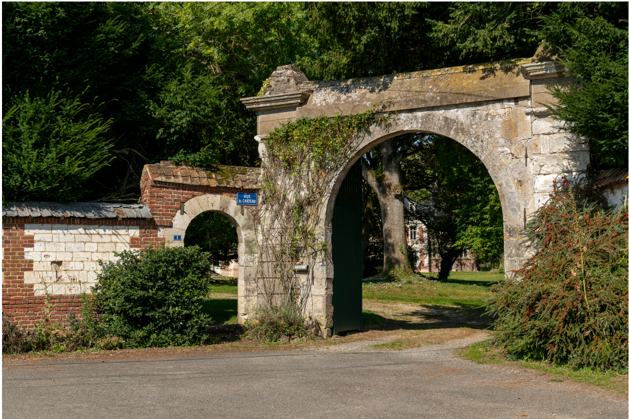
Porche et entrée piétonne.
