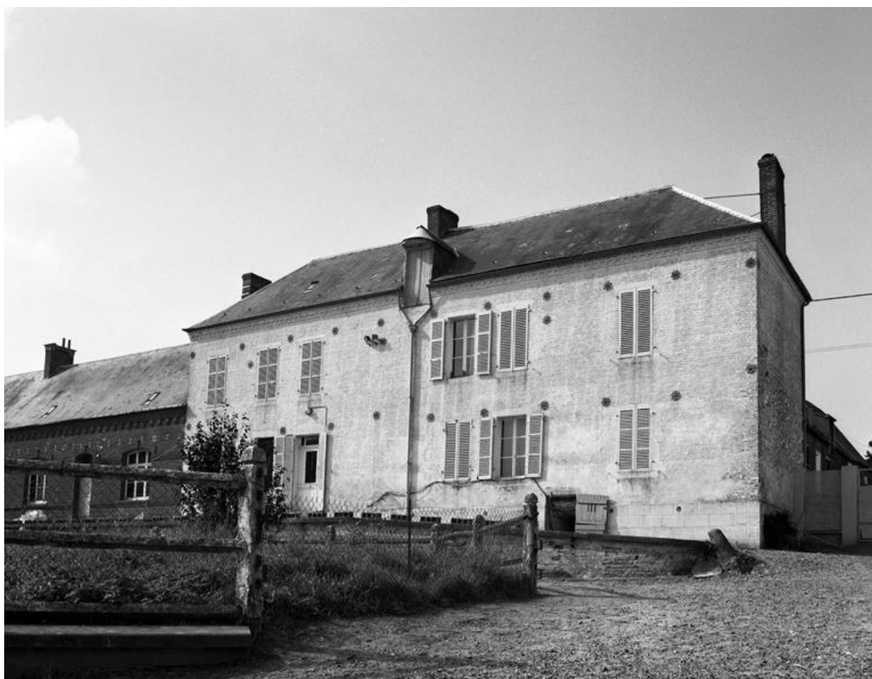
Le logis. Façade sur la cour.
