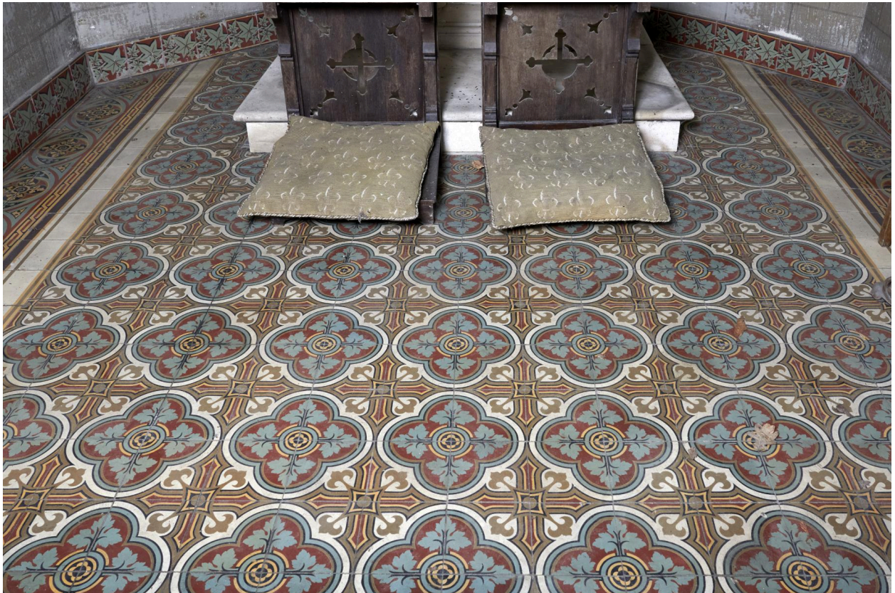
Détail du sol en carreaux ciment.
