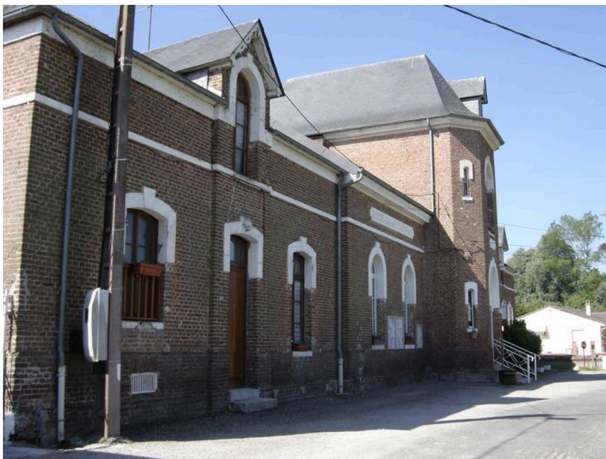
Vue sur l'aile sud.
