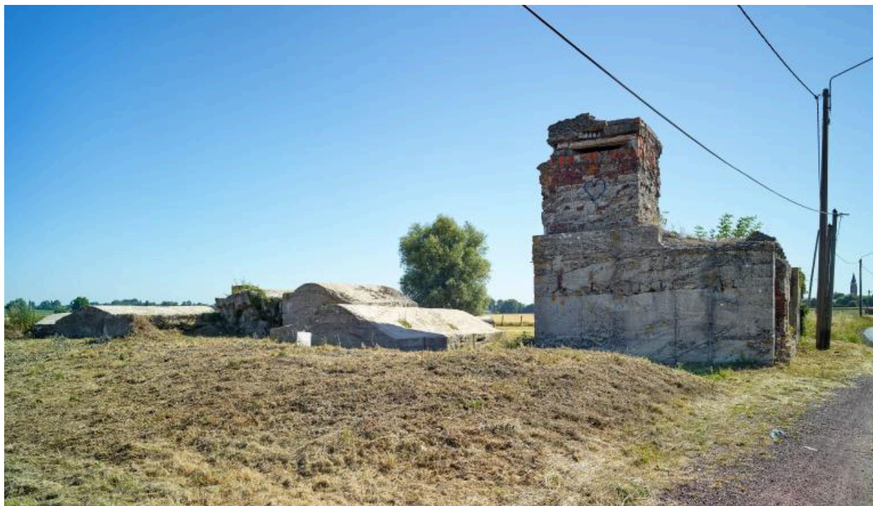
Vue antérieure des casemates a à f, vers le nord-est.
