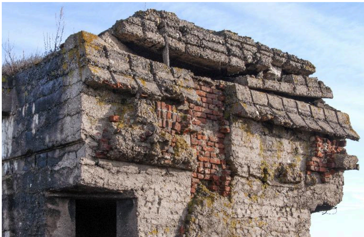
Elévation ouest, détail de l'embrasure d'observation
