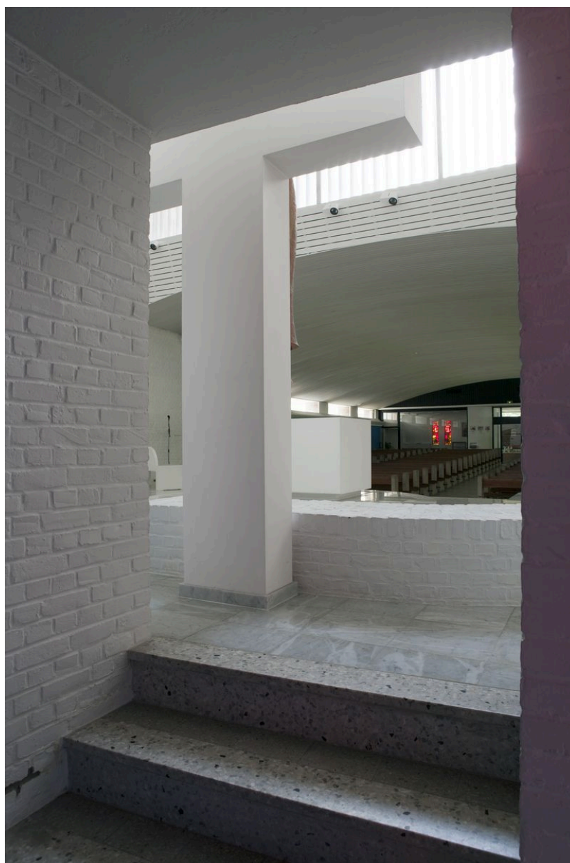
Ouvertures derrière le chœur.
