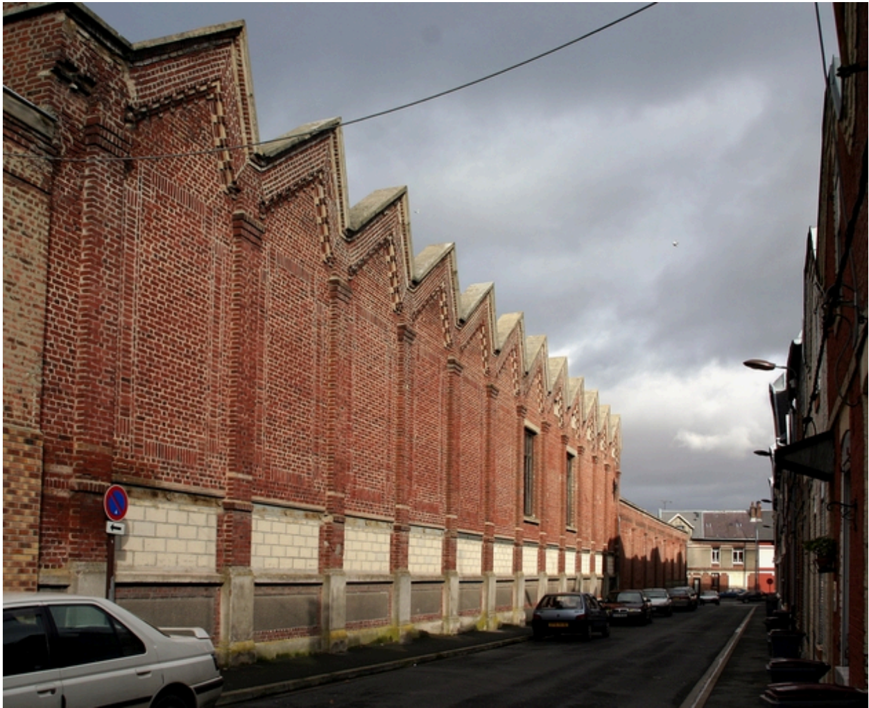
Façade sur rue des entrepôts de produits manufacturés.
